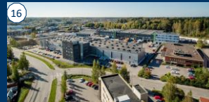
TIILITIE 6 Vantaa 3 306 m 2
